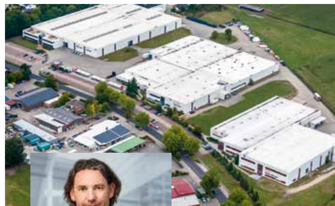
Werk 2 in Lingen/Deutschland plant 2 in Lingen/Germany
